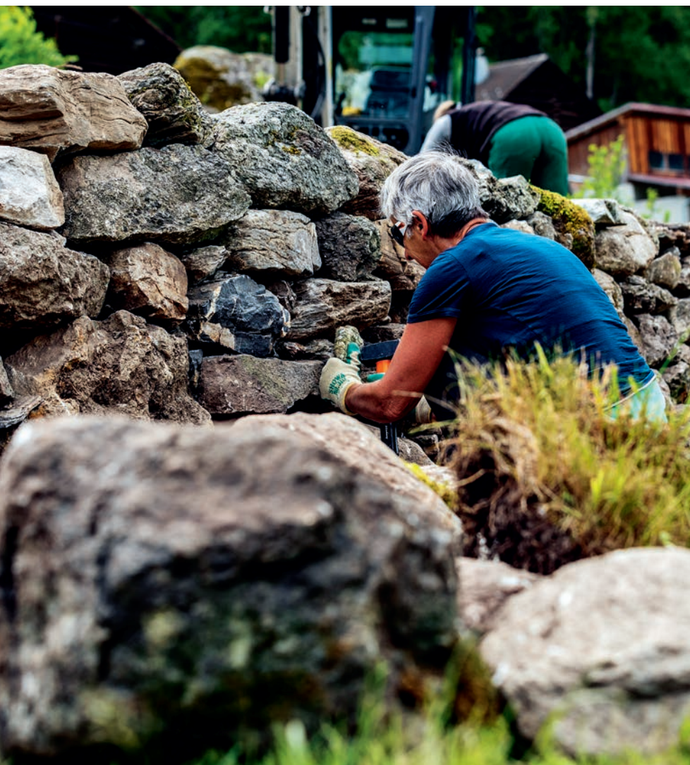
Arbeiten an der Mauerbasis und der Hintermauerung.
