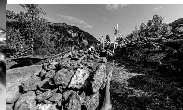
Behauen, einpassen, überprüfen: Damit jeder Stein ohne Mörtel sauber aufliegt.
