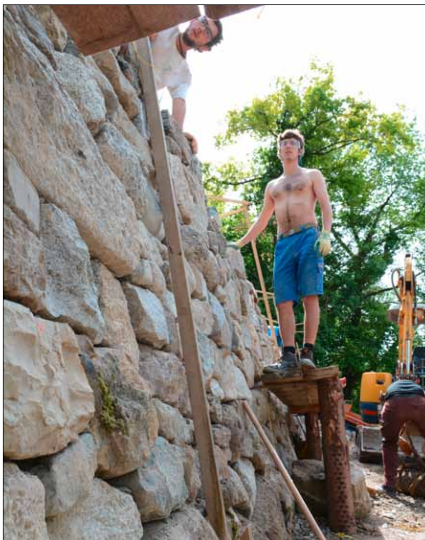
Stein um Stein: Zivildienstleistende arbeiten an der Sanierung der Trockenmauern im Schutzgebiet «Märxli» oberhalb von Vogelrüti. Foto: flk
