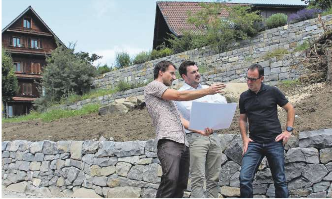
Stefan Rey, Projektleiter Artenschutz/Datenbanken der Baudirektion (von links), Baudirektor Florian Weber und Grundeigentümer Beda Schlumpf vor der sanierten Trockensteinmauer.
