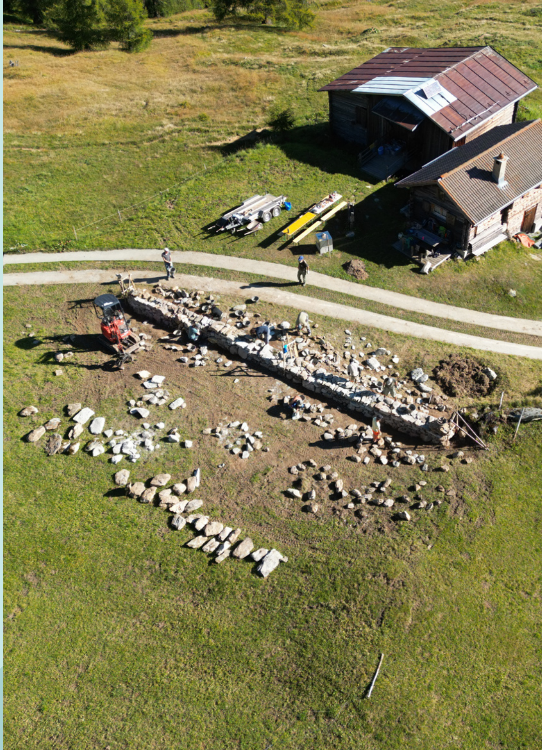
Trockenmauerbaustelle 2025 in Dumagns, Val Schons, Graubünden.
