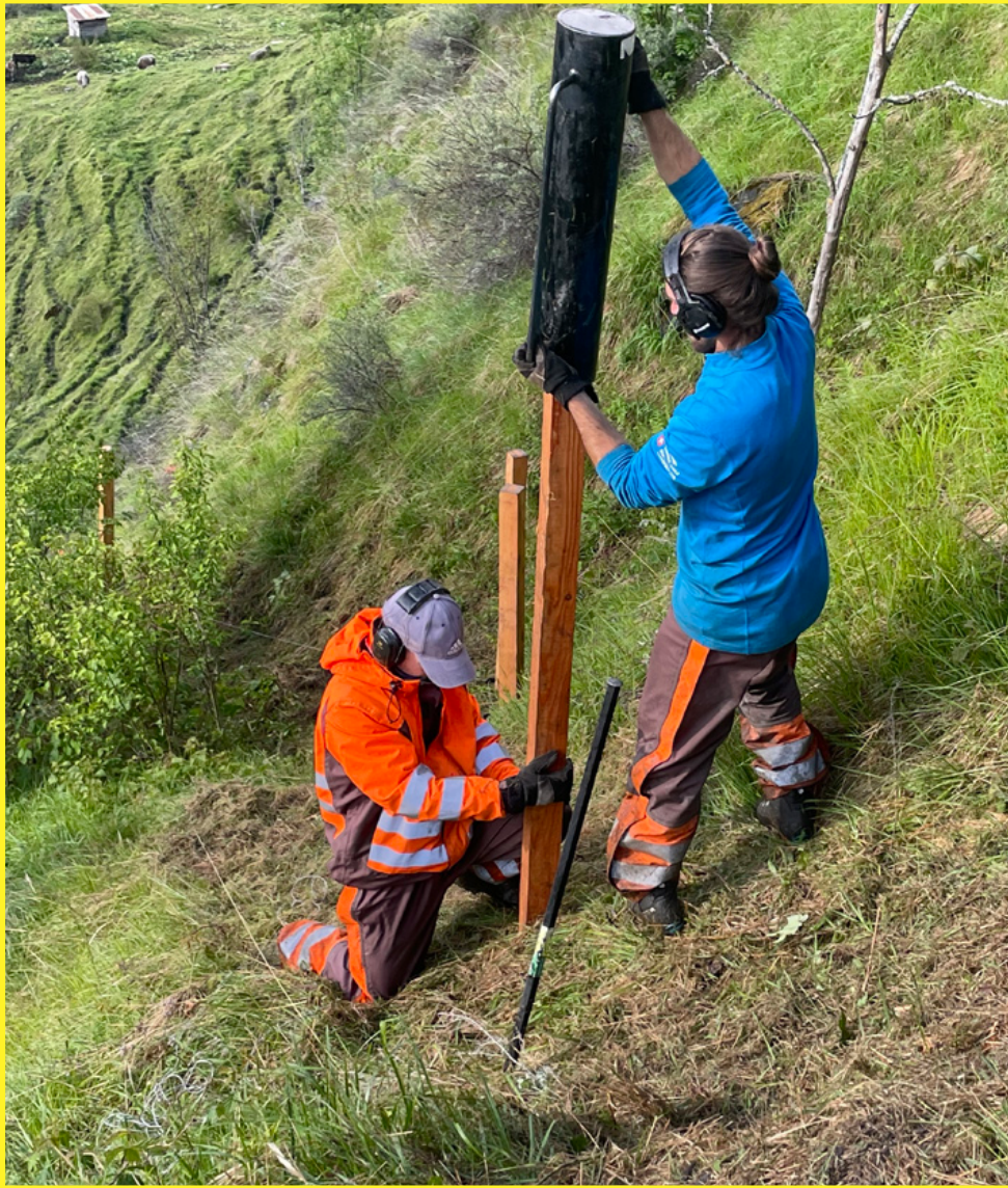
Zaunbau im TWW Chischagl, Degen.
