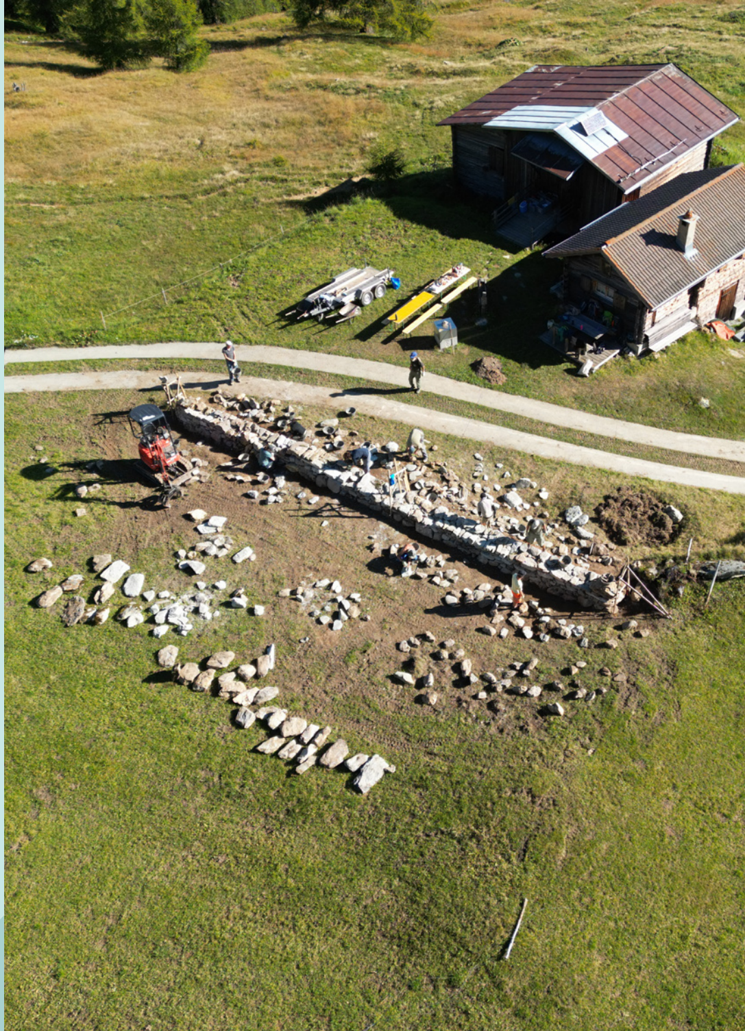
Chantier mur de pierres sèches 2025 à Dumagns, Val Schons, Grisons.
