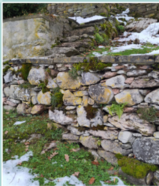
Semaine mur de pierres sèches
