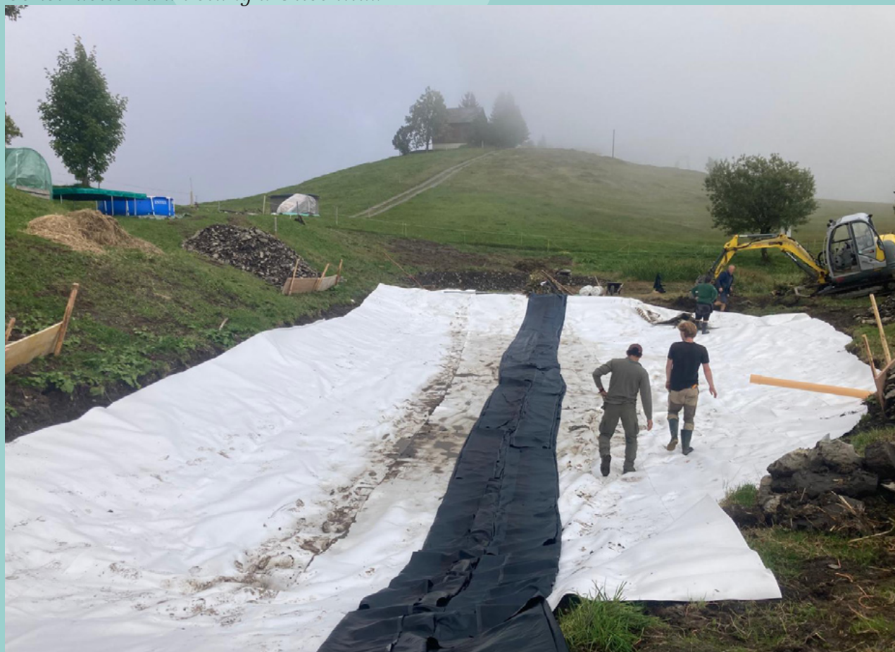
Construction d'un étang à Gitschital.
