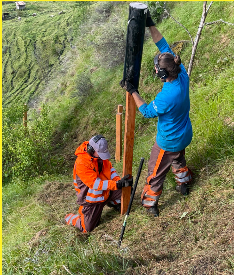
Construction d'une clôture dans la PPS de Chischagl, à Degen.
