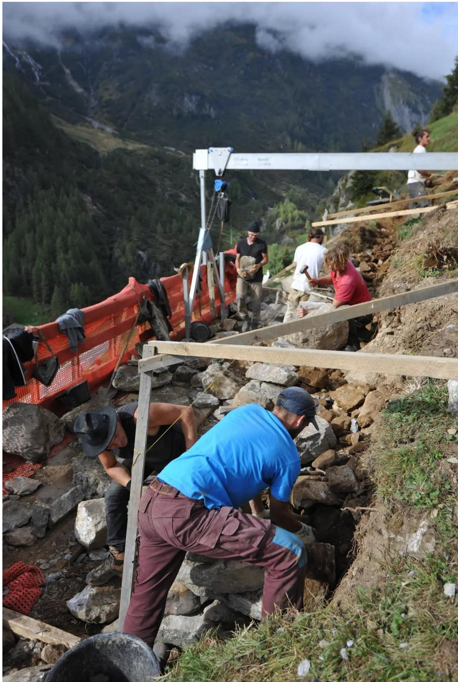
Stein um Stein ... So werden die alten und teilweise stark beschädigten Trockenmauern wieder aufgebaut.
