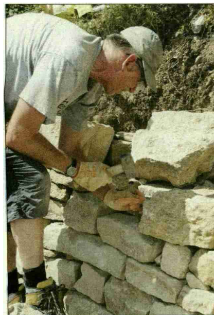
Jeder Stein wird passgenau in die Trockenmauer eingebaut
